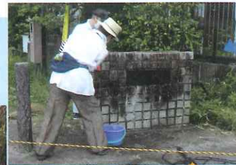
草刈り機での除草と高圧洗浄機で汚れを落とします。
