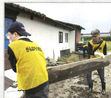
▲敷地内に流れ着いた資材も連携 プレーで次から次へと運び出し ました。
