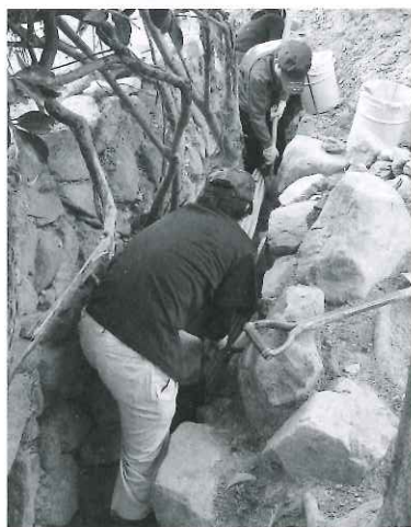
▶水路から土砂を掻き出す作業。
