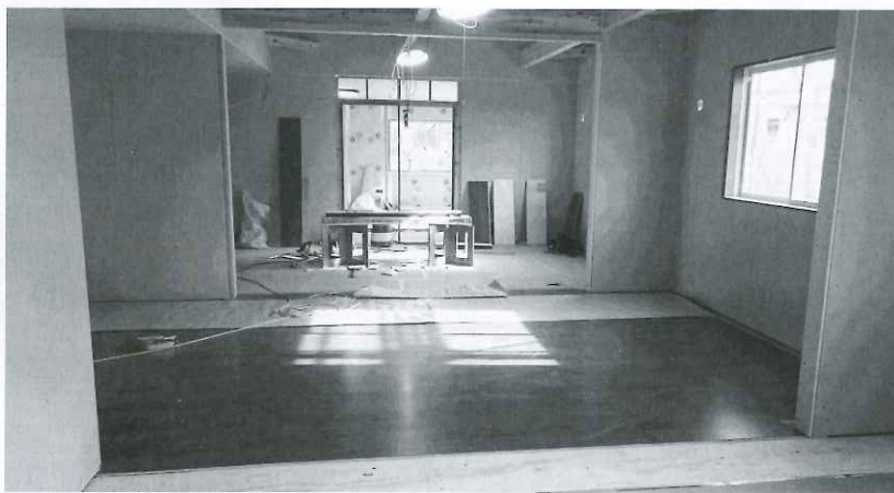
▲内装工事中の事務所内観 (H30年12月時点)
